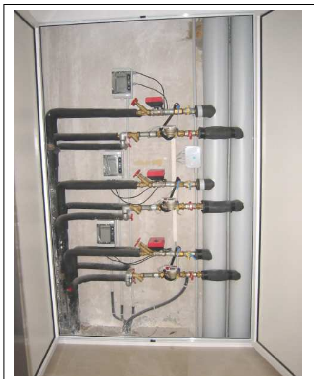
Fig. 3 : Centraline autonome d'utenza
