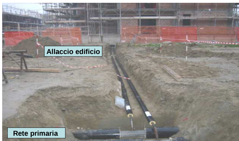
Fig. 1 : Rete di teleriscaldamento
